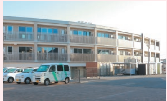
サービス付き高齢者向け住宅「コープの家」外観
